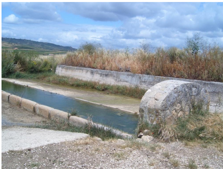
Foto - Abbeveratoio Gulfa Grande
